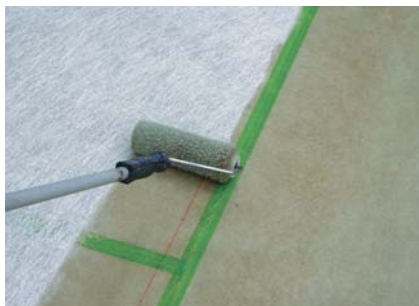
下塗~FRPライニング
