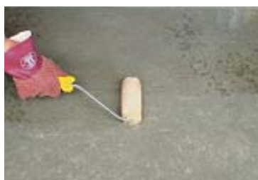
ポリキュートPC-640FXT塗布 (下塗工程)
