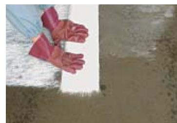
ガラスマット#450敷設
