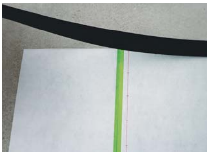
端末処理(FP端末テープを貼着し転圧) ※テープを貼着した状態での放置は膨れ・水分付着の原因
