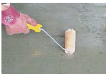
ポリキュートPC-640FXT塗布 (FRPライニング工程)
