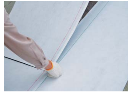
FPシートの張り付け (入隅線から100mm離して貼着する)
