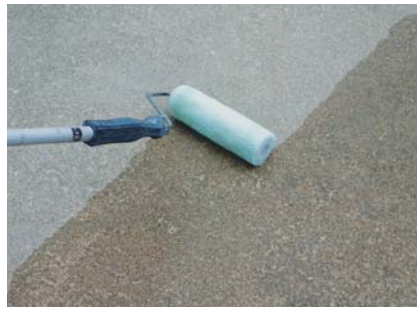
パイオニャシーラー#100塗布
