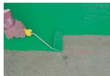
着色ポリキュートPC-640FXT塗布 (中塗工程)
