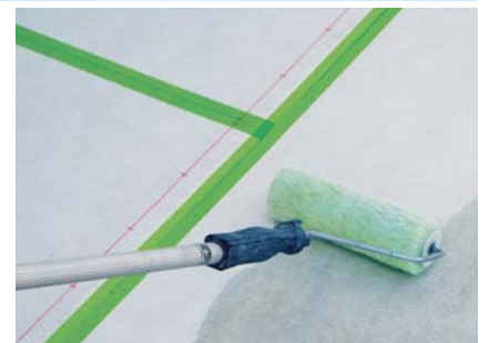
パイオニャシーラー#100塗布 (適用工法の工程 プライマーより施工)
