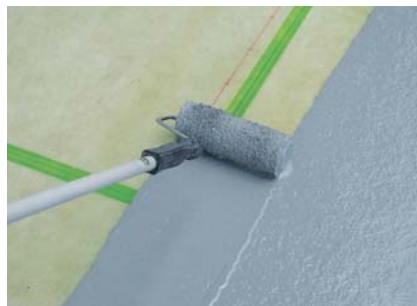
着色ポリキュートPC-640FXT 塗布 (中塗工程)
