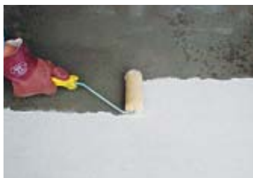
パイオニャシーラー#100塗布
