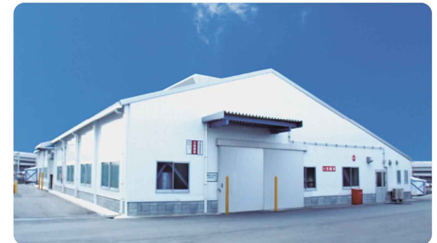
塗料製造工場
