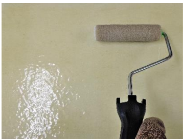
硬化後 P-715TN をローラーで塗布
